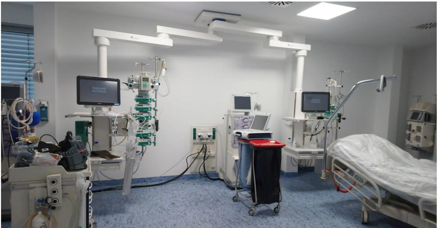
Die Systeme lassen sich als Einzelstativ - SINGLE - oder als Doppelstativ - TANDEM - konfigurieren. Damit kann der Arbeitsbereich bei effizienter Ausnutzung des verfügbaren Raumes stark erweitert werden. Ein Wechsel des Arbeitsplatzes durch Verschwenken der Systeme ist problemlos möglich.
